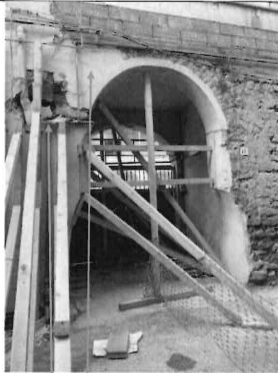
48 bis_Arco posto in corrispondenza al portico d'accesso al complesso immobiliare
