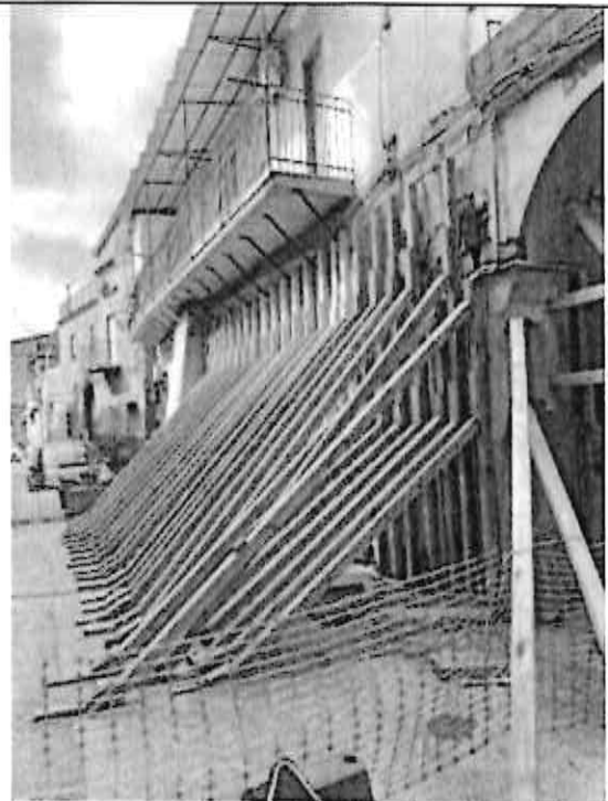
4 _Puntellamento della facciata fronte Sud
