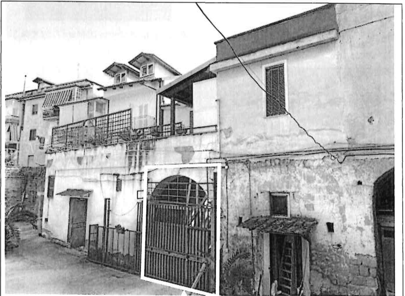
Portico d'ingresso al complesso edilizio
