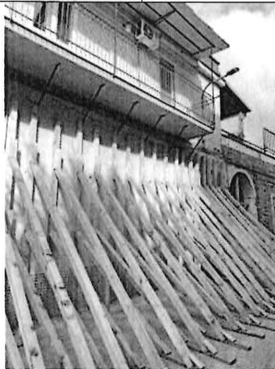
7_Puntellamento della facciata fronte Sud
