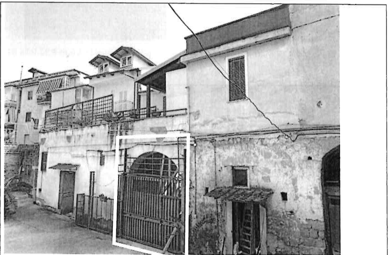
Portico d'ingresso al complesso edilizio
